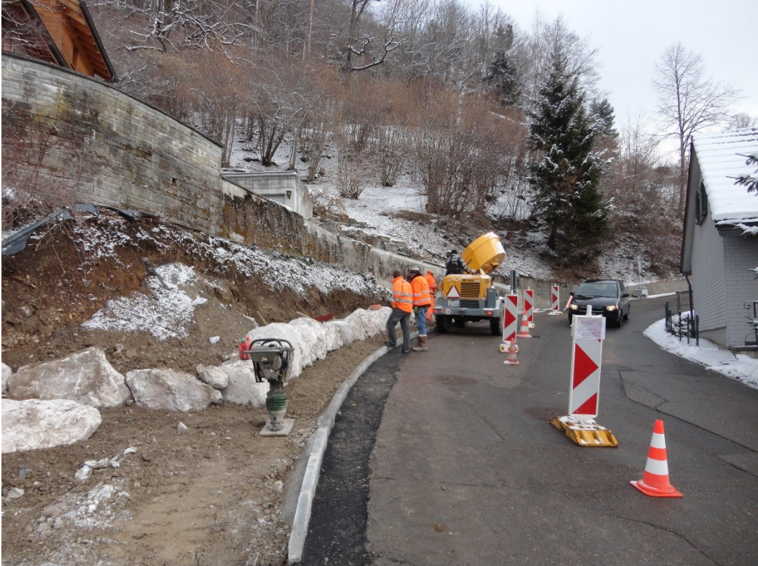
Wiederherstellung der Strassenböschung; Foto vom 15.03.2013
