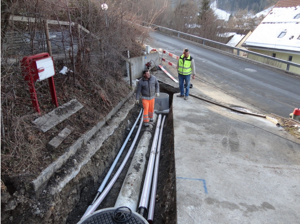
Seitlicher Anschluss; Foto vom 08.03.2013
