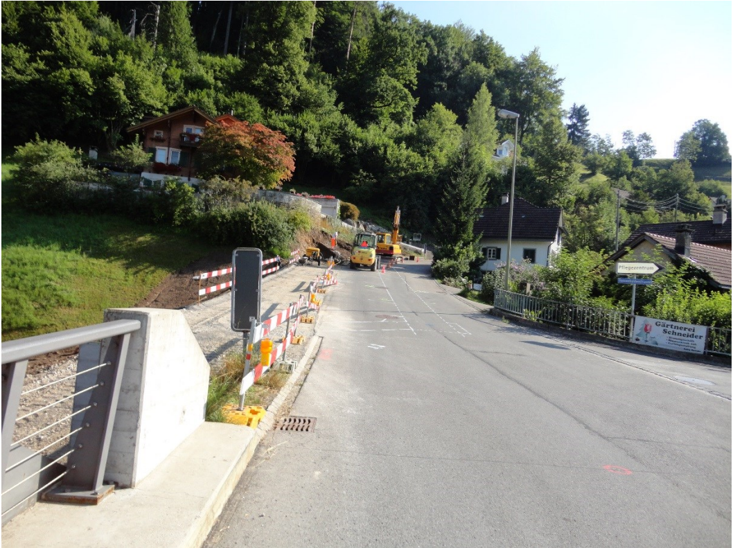
Verbreiterung der Fahrbahn; Foto vom 10.08.2012
