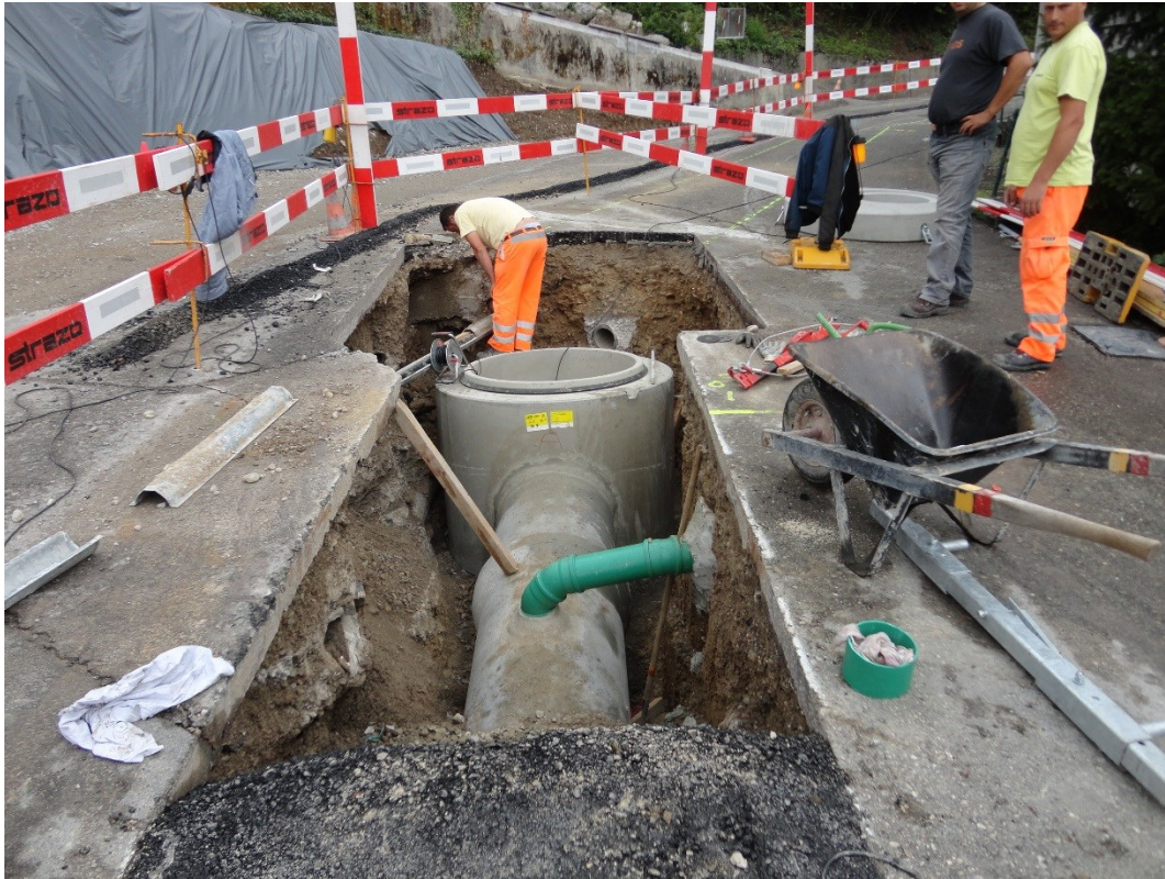
Kontrollschacht KS 1; Foto vom 04.09.2012
