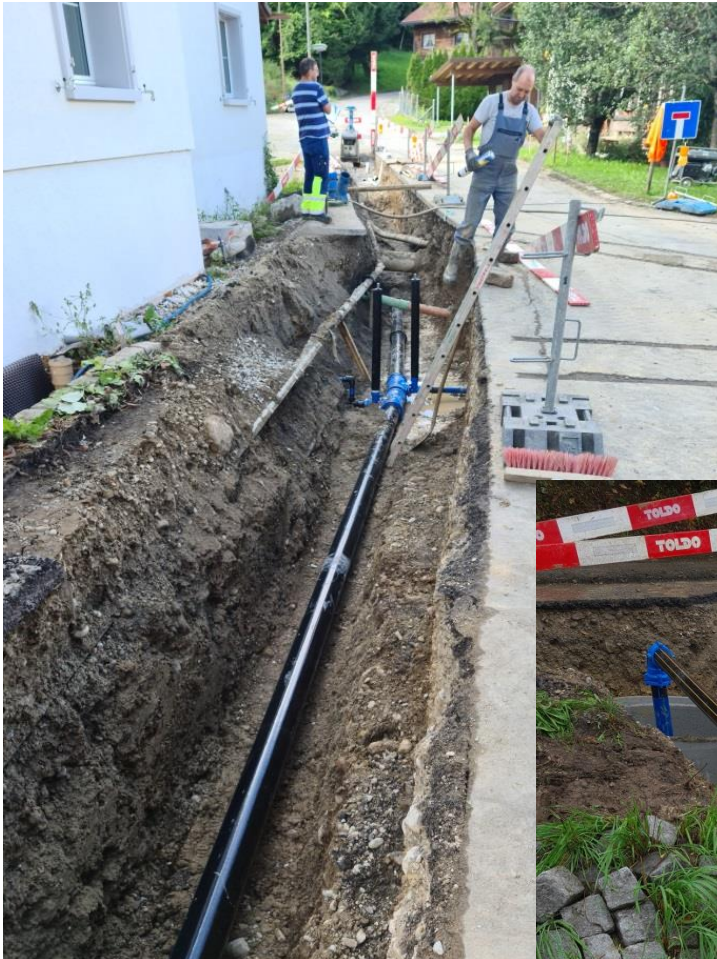
Bild oben: Neue Wasserleitung
