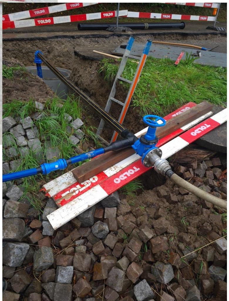
Bild rechts: Wasseranschluss für die Feuerwehr und Abgang prov. Wasserversorgung
