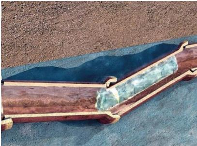
Verschobene Rohrverbindung, schadhafte Dichtung, Infiltration, Abrieb
