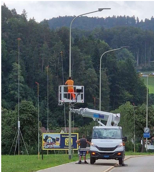
Abbildung 2: Montage der Halterungen
