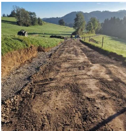
Abbildung 5: Sanierung der Dürstelenstrasse
