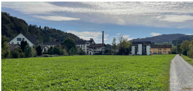
Ansicht auf das Ensemble und die Rückseite der Wohnhäuser
