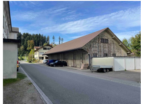
Südostansicht Magazin/Scheune Wohnhaus.
